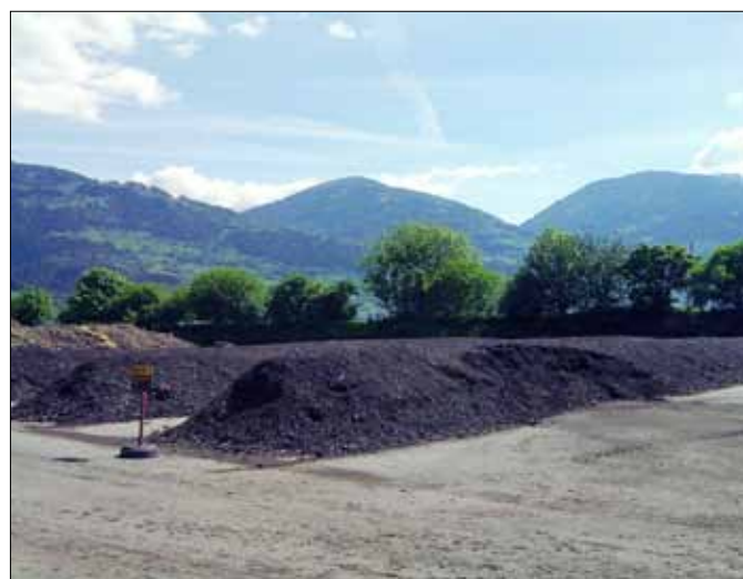
Die Kompostieranlage der Stadt Lienz.
